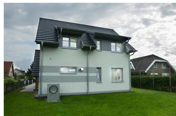
Nord-Ansicht M1 Effizienzhaus Plus
