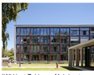
IWU legt Zahlen zu Mehrkosten bei energieeffizienter Sanierung vor. Bild: Dena
