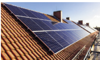
Kollektive Nutzung von PV-Strom ist komplex Foto: © IBC Solar
