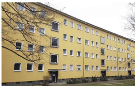
Unter Denkmalschutz: Ca. 30.000 m 2 Fassade wurden fugenfrei mit nur 2,5 cm Dämmstärke ohne Veränderung der Gebäudeoptik denkmalverträglich gedämmt.
