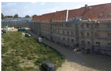
Mehrgeschossiger Wohnungsbau: Ca. 6.000 m 2 Fassade eines betagten Gebäude-Ensembles wurden mit Aerogel-Dämmputz EnEV-gerecht saniert.
