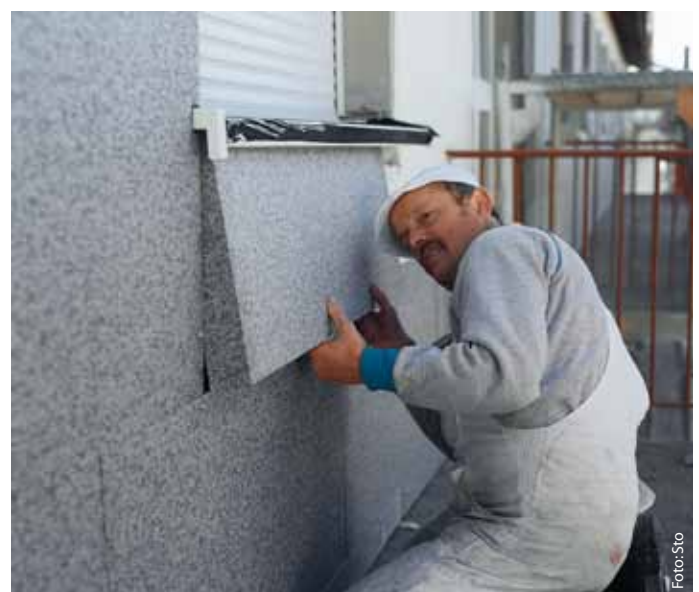
Beim Einbau von WDVS ist Sorgfalt gefragt.
