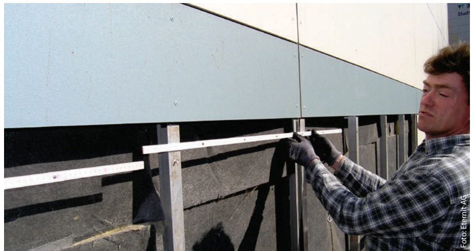
Bei Vorhangfassaden sind Dämm- und Witterungsschicht getrennt.
