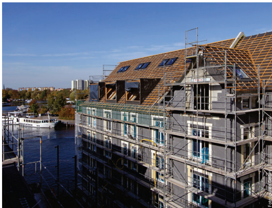
Im Rohbau ist der Brandschutz mit purenotherm Brandschutzriegeln von weitem sichtbar. Das Material hat viele Vorteile.
