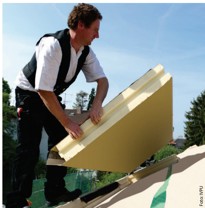
Eine Aufsparrendämmung vermeidet Wärmebrücken.
