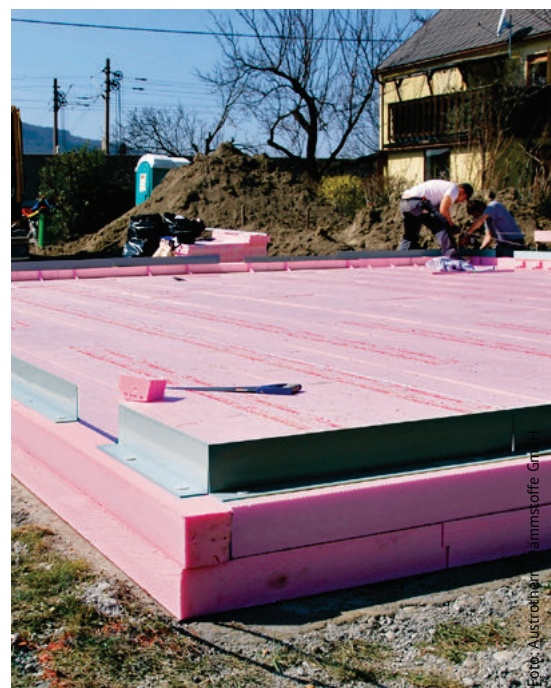
Austrotherm XPS TOP 70 ist bestens für die Dämmung unter der Bodenplatte geeignet.
