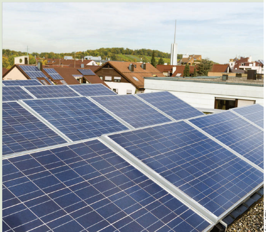
Eine Solaranlage bringt hohe zusätzliche Belastungen für die Dämmschicht eines Flachdachs mit sich. Nötig sind hoch druckbelastbare Dämmstoffe.
