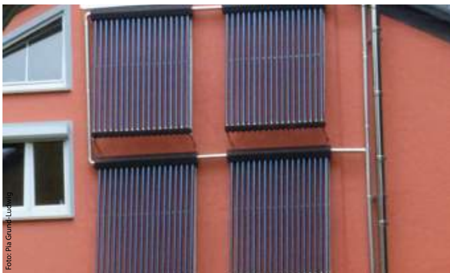
Im Zuge der Sanierung wurden hier Röhrenkollektoren leicht geneigt an die Fassade angebracht. Auf jeden Fall ein Hingucker.
