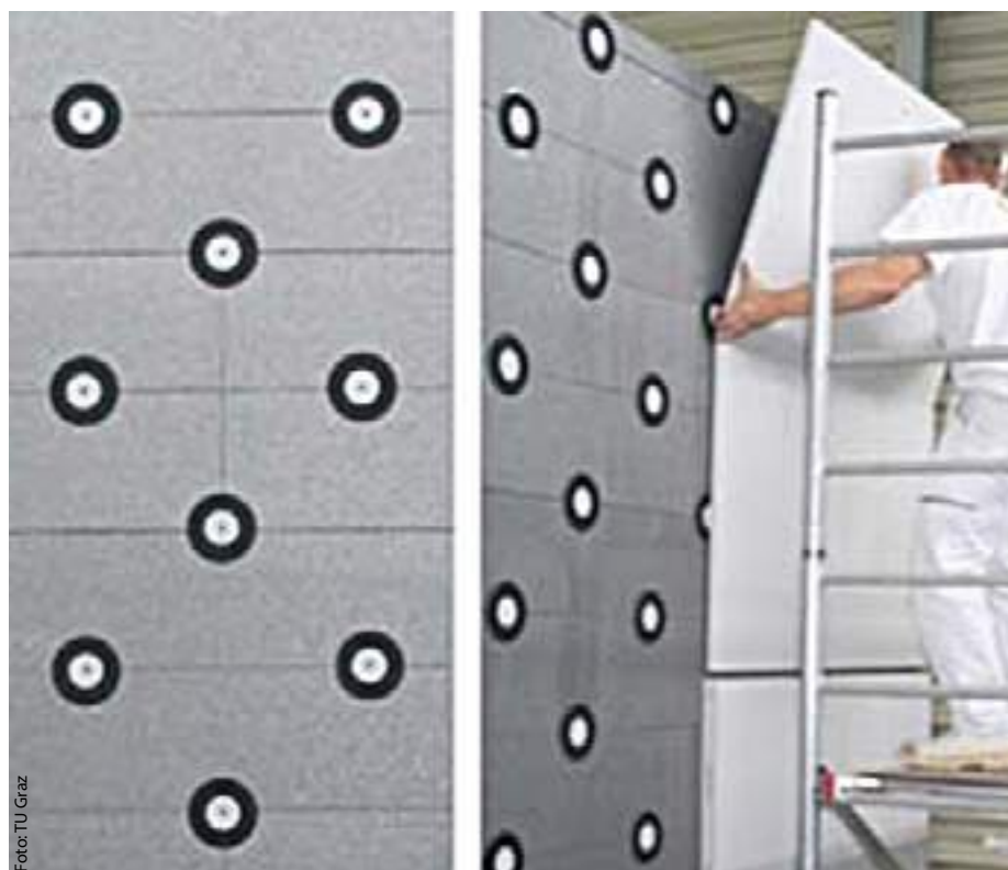
Statt mit Klebstoffen werden die einzelnen Fassadenschichten im Projekt „facade4zeroWaste“ mit Klettflächen und speziell entwickelten Befestigungsdübeln miteinander verbunden.
