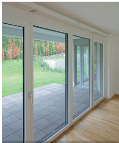
Die schlanken Schüco Vento-Therm-Lüftungselemente sind völlig unauffällig in die innere Laibung integrierbar.
