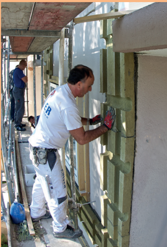
Die Verkleidung der Laibung ist vorgefertigt (oben). Das verringert die Einbauzeit. In der Dämmung (unten) sind Kanäle für Lüftung vorbereitet.
