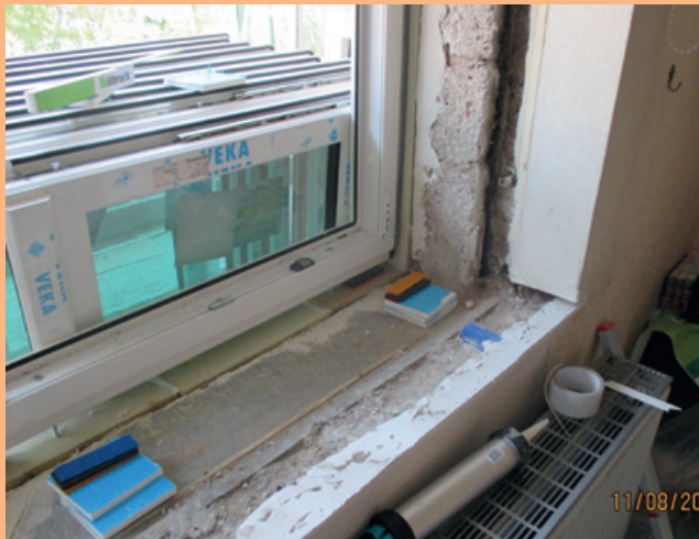
Die Verkleidung der Laibung ist vorgefertigt (oben). Das verringert die Einbauzeit. In der Dämmung (unten) sind Kanäle für Lüftung vorbereitet.
