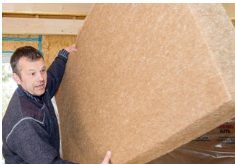
Dämmplatten aus Jute werden zwischen die Dachsparren geklemmt.
