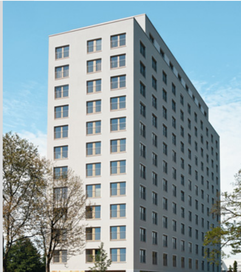
Das Objekt Lyoner Straße 30 in Frankfurt a. M. nach dem Umbau: Bodentiefe Fenstertüren verleihen dem Gebäude das Aussehen eines modernen Apartmenthauses.
