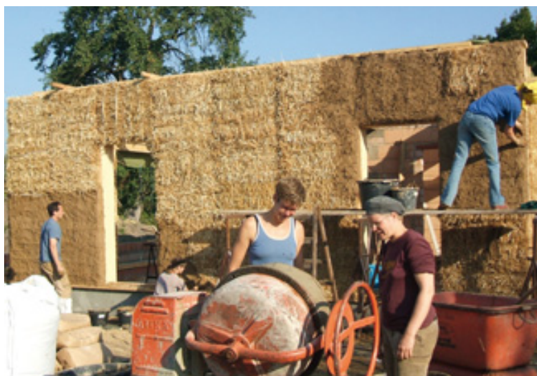
Stroh hat seit kurzem eine Zulassung als regulärer Baustoff. Man kann damit dämmen oder ganze Häuser bauen.
