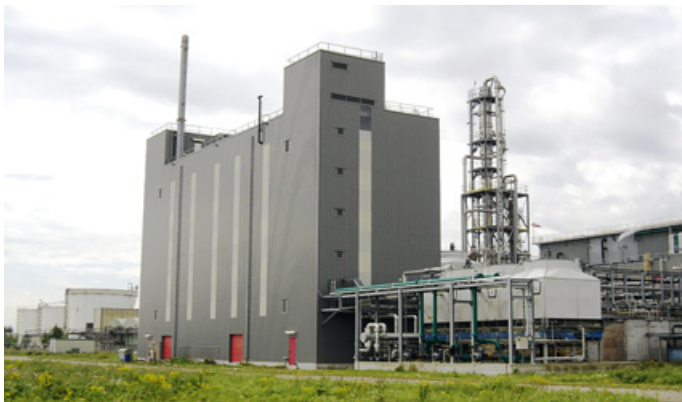
Neben einer bestehenden Fabrik in Terneuzen soll die Demonstrationsanlage entstehen.
