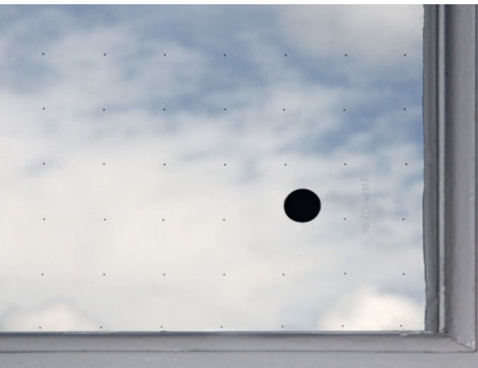
Verschlusspunkt und Stützen in einem Vakuumfenster.
